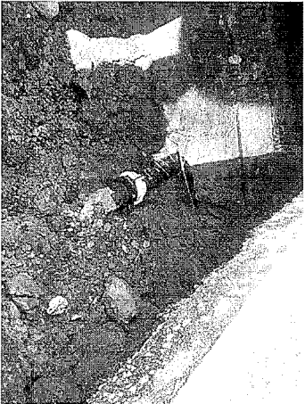
(漏水事故による配水小管の漏水状況及び修理後の状況)
